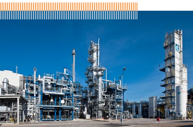
Wasserstoffherstellungsanlage der Air Liquide
